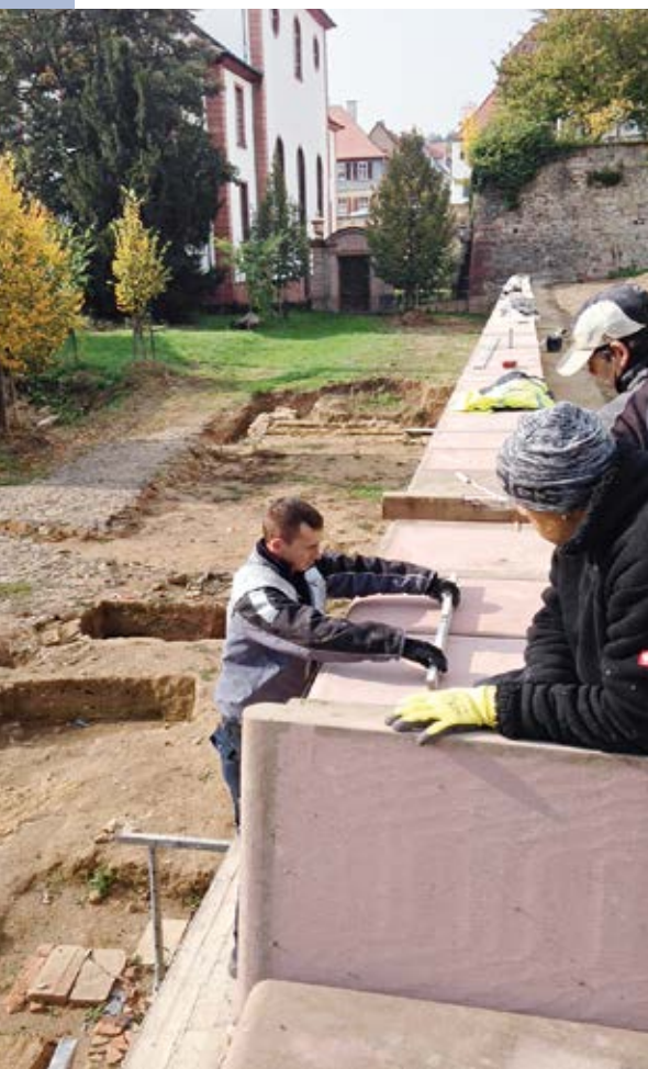
Die untere Terrassenmauer ist bereits wieder errichtet und mit Abdeckplatten belegt.
