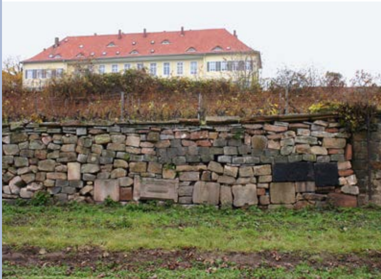
In der wild zusammengemauerten Lücke, wo sich früher die Kaskade befand, sind allerlei Spolien zu finden. Sie lassen wichtige Rückschlüsse auf die Werkstückgestalt zu.
