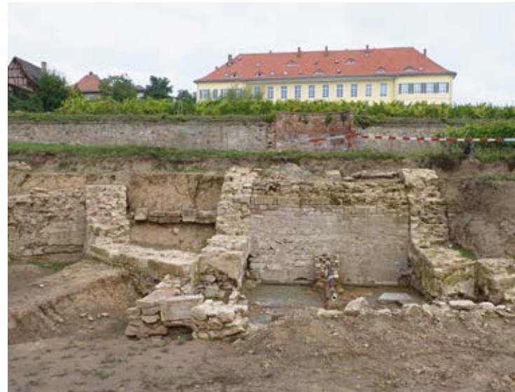
Die Kaskade wurde unter Verwendung diverser Fundstücke mehrfach überformt. Ihr Wiederaufbau ist Teil der Zielformulierung der Kirchheimbolandner.
